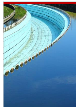
Biogaz din epurarea apelor uzate
